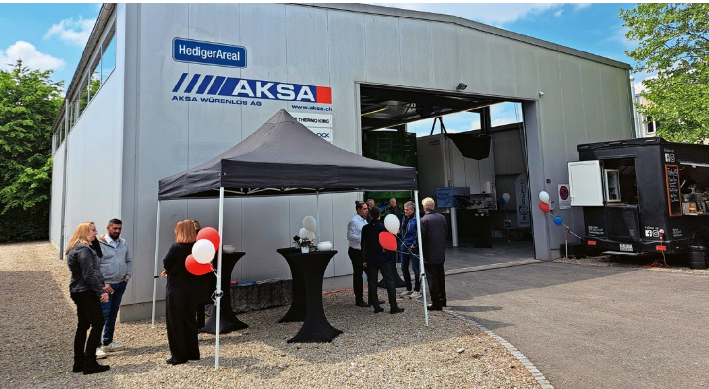
Die grosse Halle bietet Platz für mehrere Kühlaufleger und ergänzt so die beiden mobilen Service-Fahrzeuge optimal.
