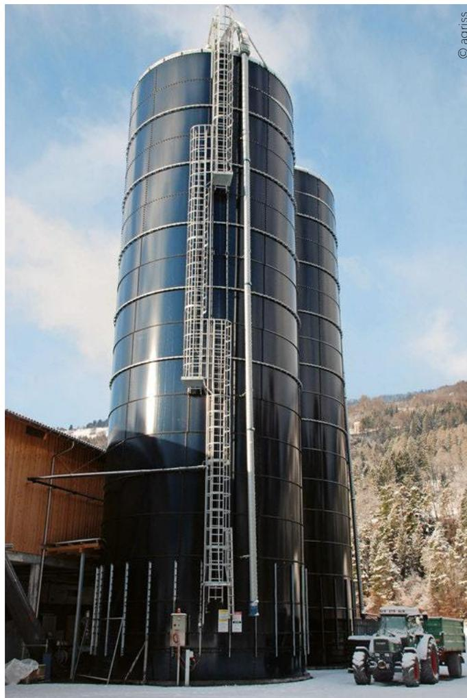
*Zwischenpodeste oder versetzt angebrachte Leitern erlauben bei langen Aufstiegen eine Pause.*
