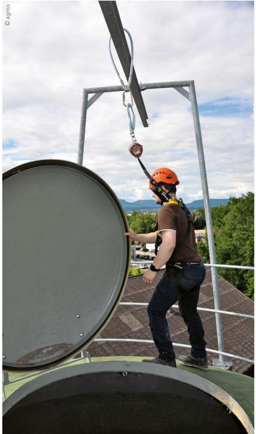
Absturzsicherung beim Arbeiten auf dem Silodach mittels PSAGa an der Kranbahn.
