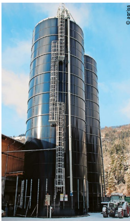
Des paliers intermédiaires ou des échelles décalées permettent de faire une pause lors de longues ascensions.
