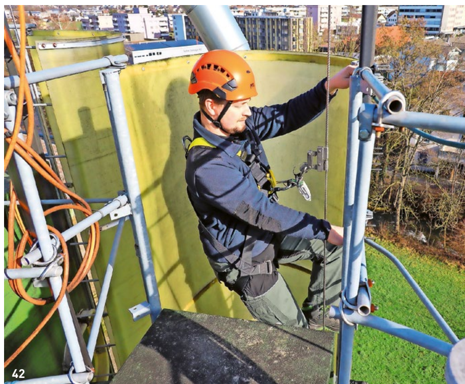
Protection contre les chutes lors de la montée/descente avec un dispositif antichute sur ligne de vie fixe.
