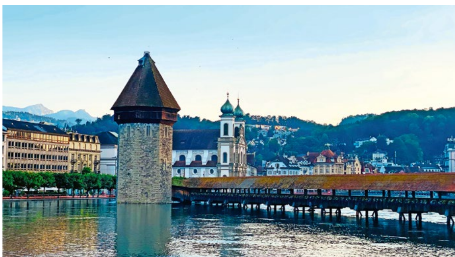
Les dommages causés par les inondations à Lucerne ont pu être limités.
