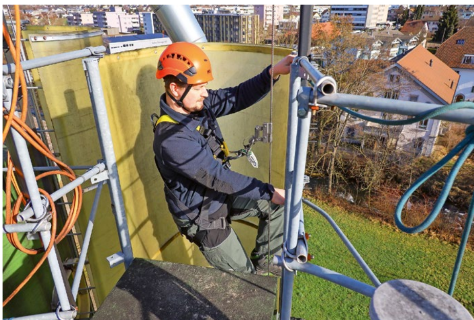
Protection contre les chutes lors de la montée/descente avec un dispositif antichute sur ligne de vie fixe.
