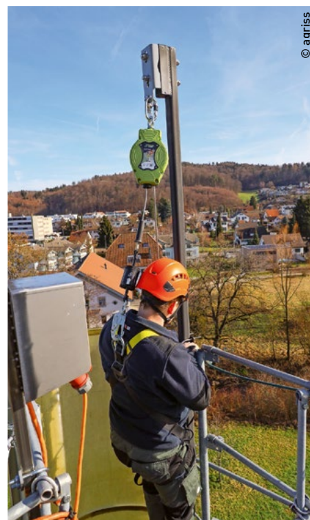
Protection contre les chutes lors de la montée/descente avec un appareil antichute (enrouleur).
