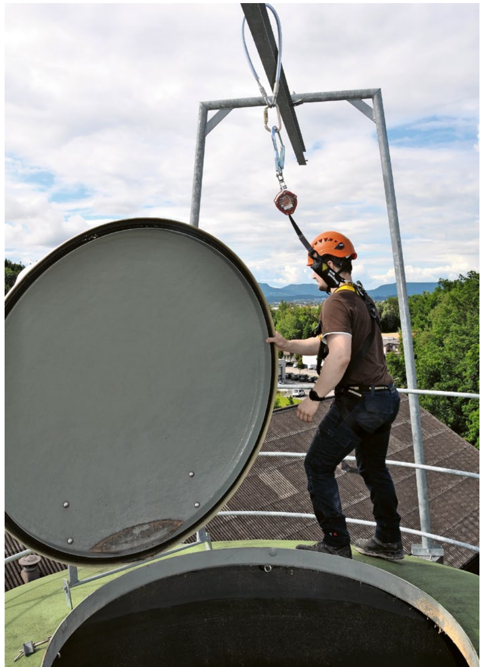
Protection contre les chutes lors de travaux sur le toit du silo à l'aide d'un EPIaC avec enrouleur sur le bras de la grue.
