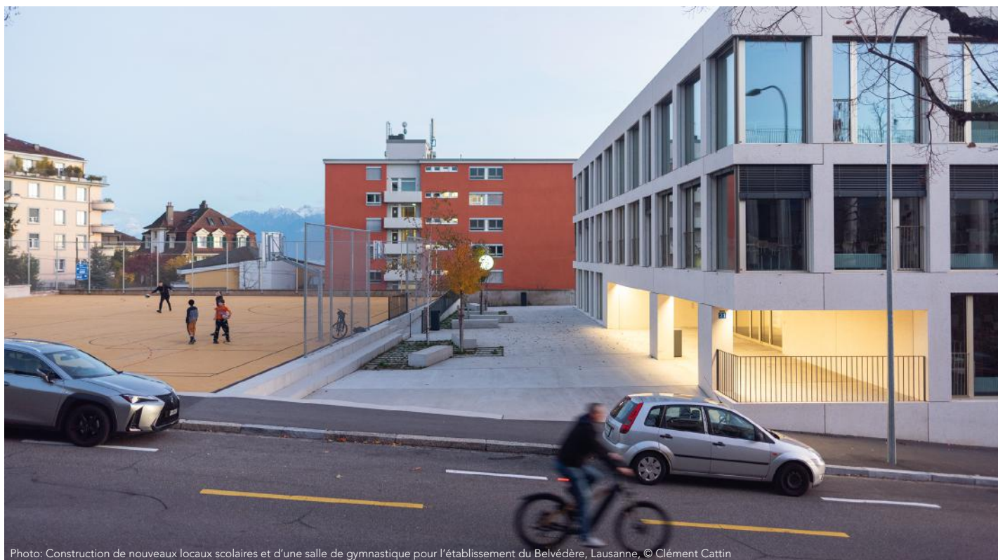
Photo: Construction de nouveaux locaux scolaires et d'une salle de gymnastique pour l'établissement du Belvédère, Lausanne, © Clément Cattin
