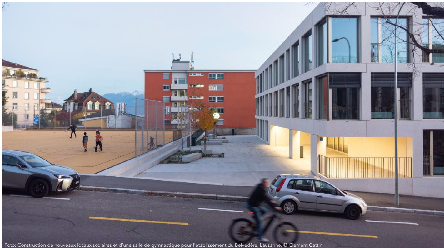
Foto: Construction de nouveaux locaux scolaires et d'une salle de gymnastique pour l'établissement du Belvédère, Lausanne, © Clément Cattin
