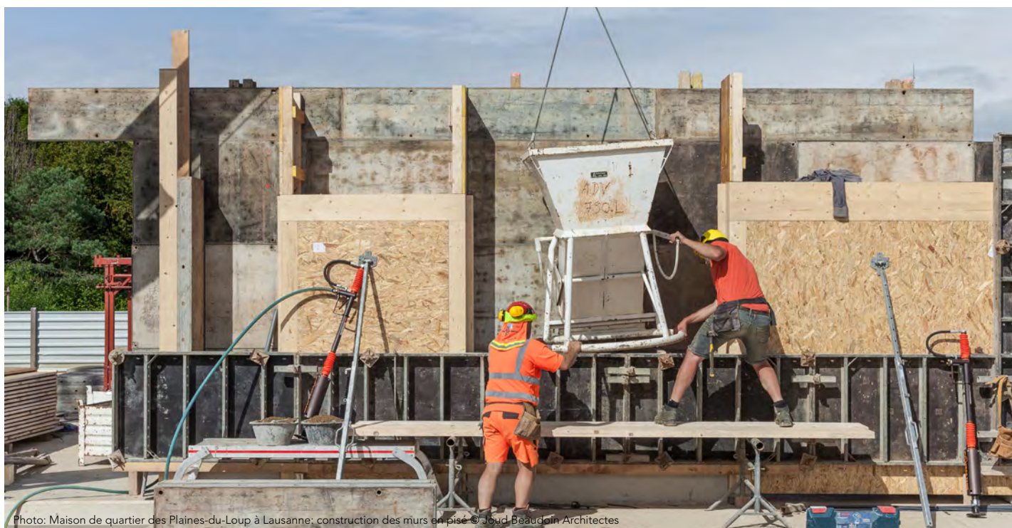
Photo: Maison de quartier des Plaines-du-Loup à Lausanne: construction des murs en pisé © Joud-Beaudoin Architectes
