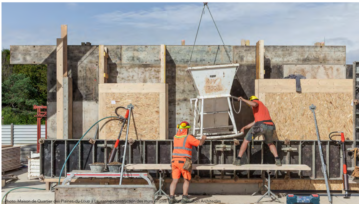
Photo: Maison de Quartier des Plaines-du-Loup à Lausanne: construction des murs en pise © Joud Beaudoin Architectes
