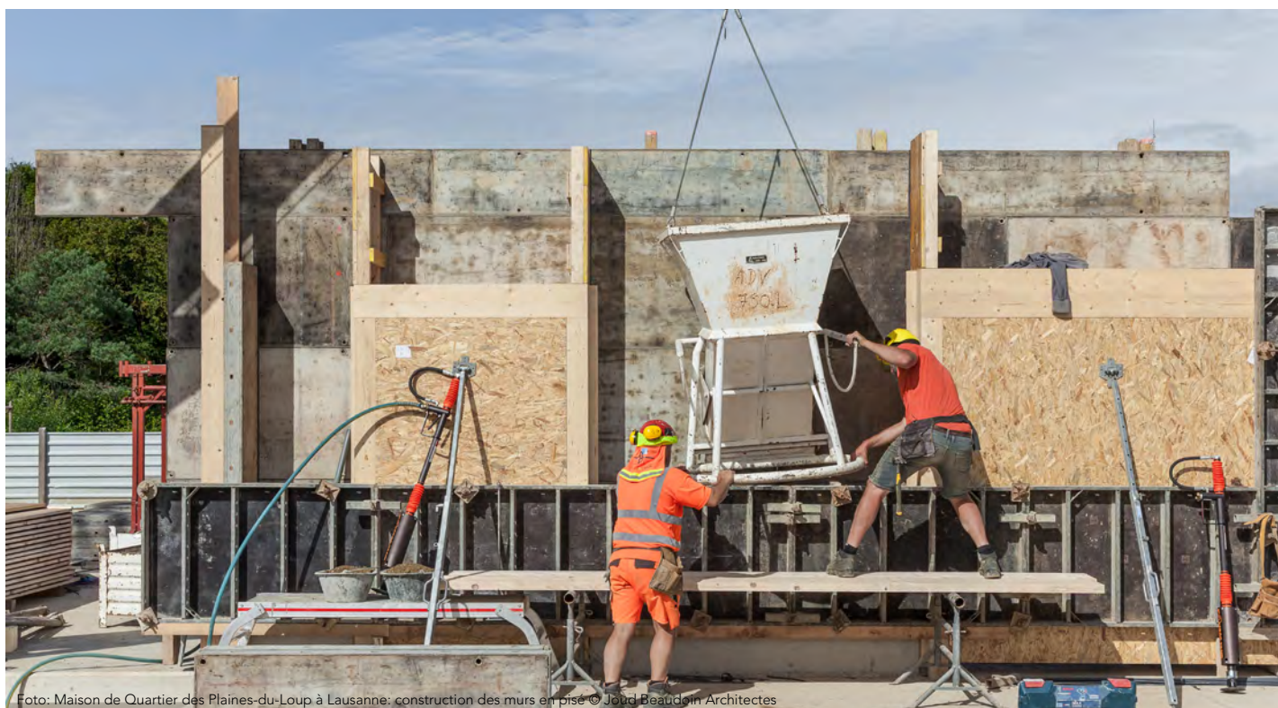
Foto: Maison de Quartier des Plaines-du-Loup à Lausanne: construction des murs en pisé © Joud Beaudoin Architectes
