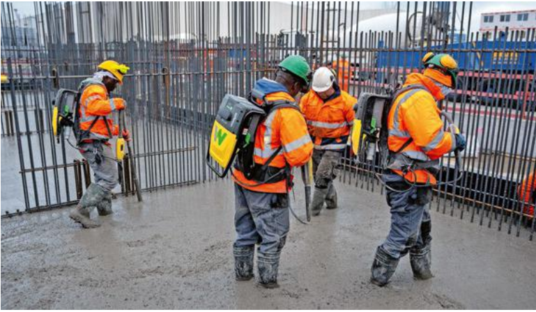
Der Akku-Umformer-Rucksack ACBe und mehrere Hochfrequenz-Innenrüttler IRFU von Wacker Neuson dienen der Verdichtung der Betonelemente.
