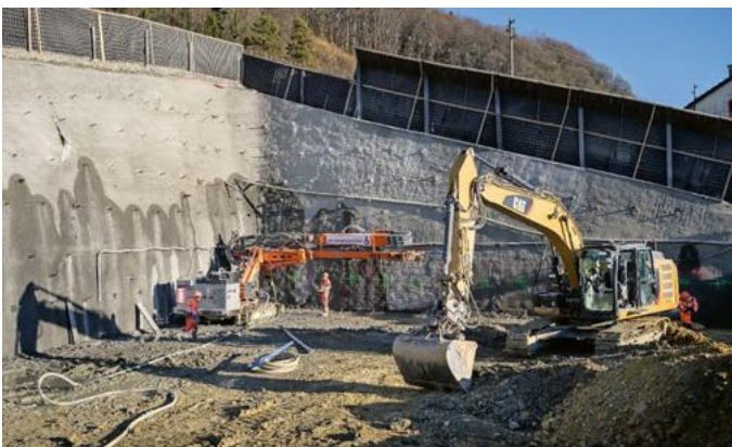
Das erste westliche Teilstück des Tunnels wird im Tagbauverfahren erstellt.
