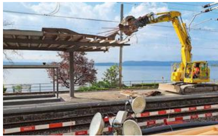
Abbruch der alten Haltestelle Twann, um das neue zweigleisige Trasse zu verlegen.
