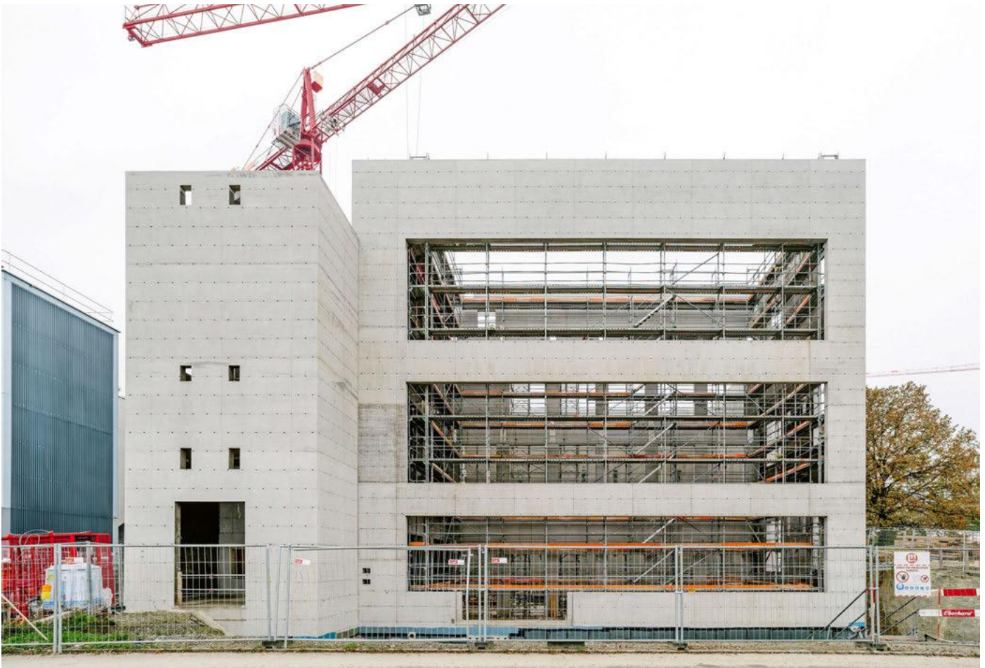
Die tragende Aussenhülle des Rechenzentrums besteht aus Sichtbeton, in dem dauerhaft CO 2 eingelagert ist.
