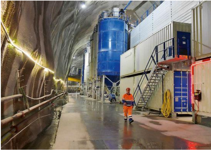
Die Betonanlage in der eigens hierfür ausgebrochenen Kaverne im Innern des Bergs.
