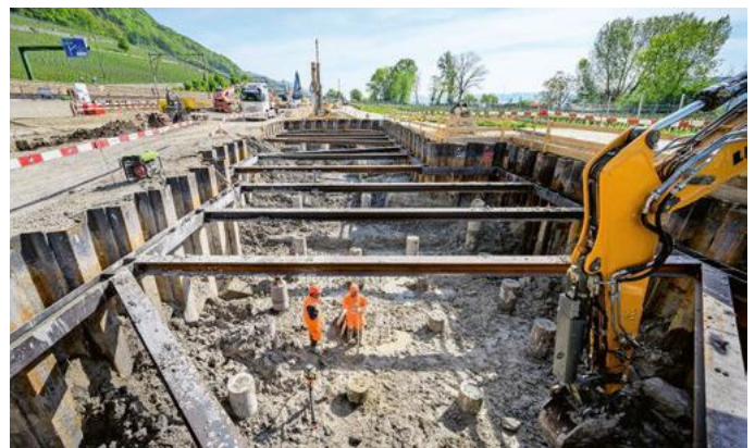
Pfährlarbeiten für das neue zweigleisige Trasse auf der Westseite des künftigen Tunnels.
