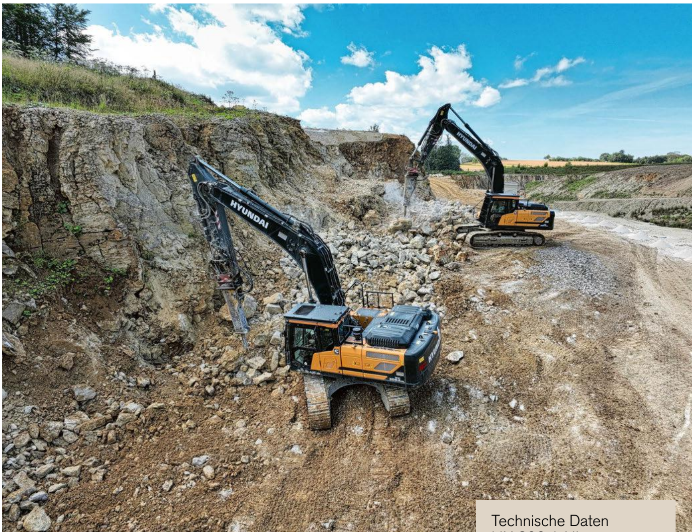
Die beiden Kettenbagger HD Hyundai HX 300 A NL des Schotterwerks Bauer beim Abtragen eines Felsvorsprungs im Steinbruch Erkenbrechtsweiler.
