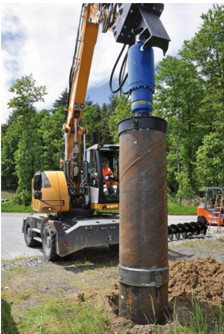
Verrohrt bohren für Rühlwände.
