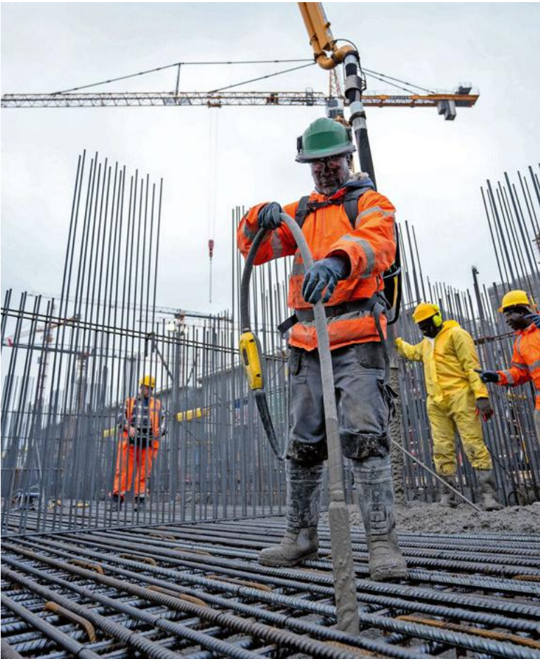
Der eingebrachte Beton muss kontinuierlich verdichtet werden.
