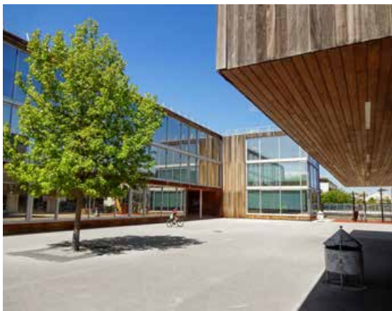
Autour de la gare de Satigny
